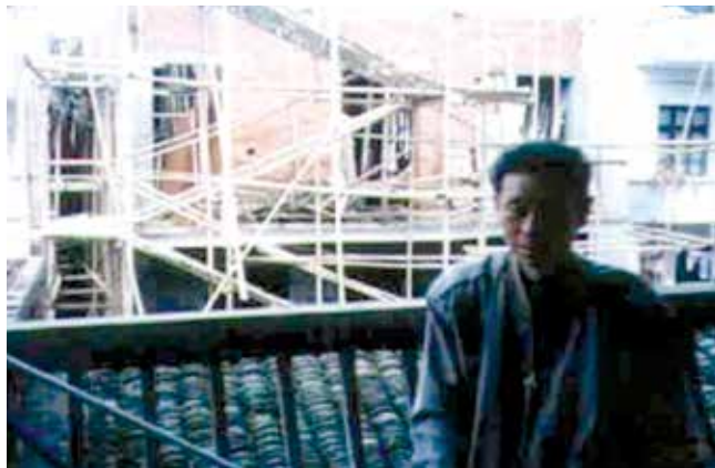
宋思定背後是興建中的新聖堂 Behind Augustine construction of the New Church Agostino: la costruzione della nuova chiesa
