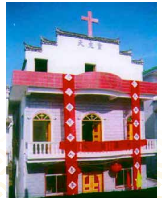
新教堂正面 Fachada de la nueva iglesia Facciata della nuova chiesa
